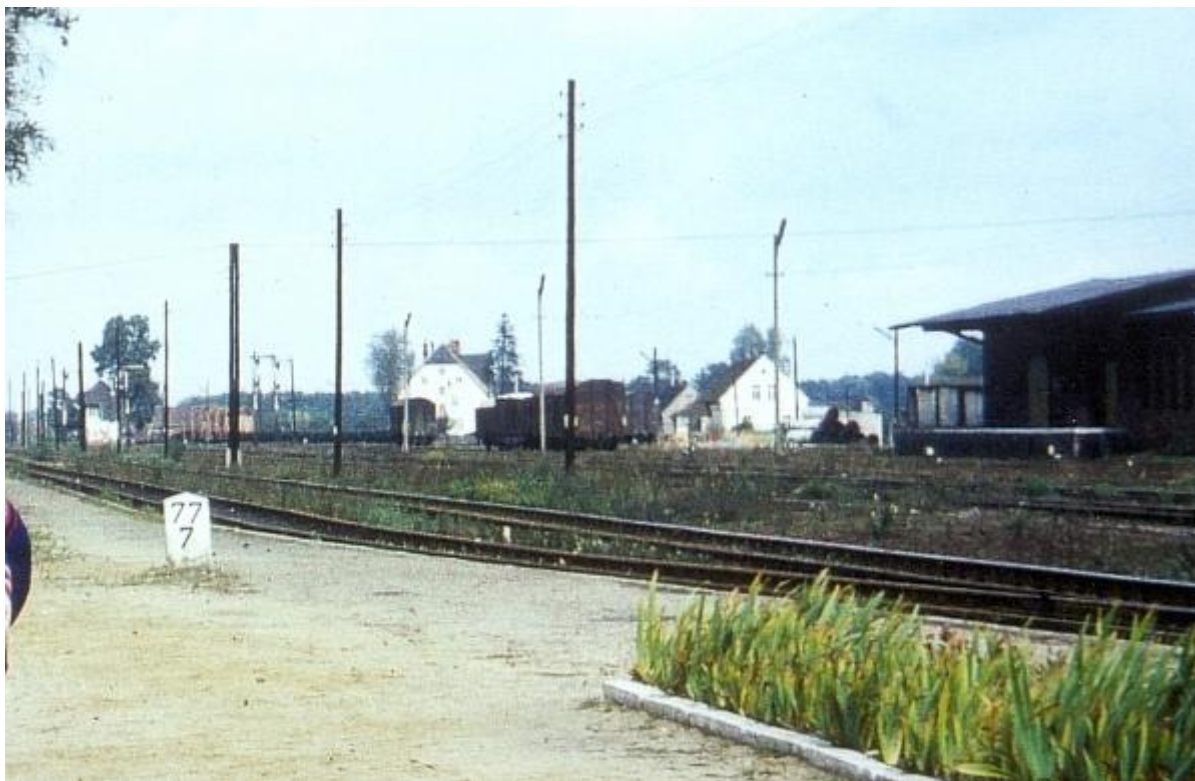
Widok na tory stacyjne w kierunku północnym. Rok 1975.
